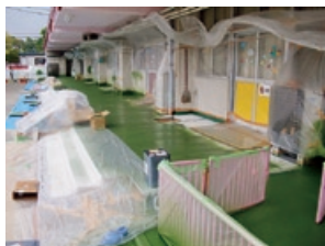
ウレタンリム 吹きつけ施工
