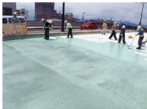
プライマー兼防水層施工状況
