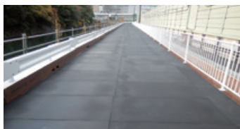
工事現場養生
